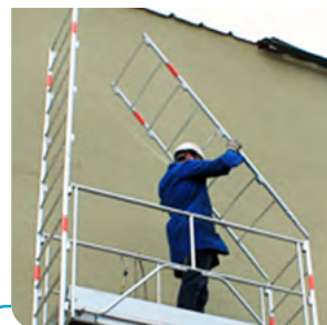
Mise en place des échelles
