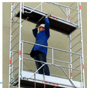
Mise en place du plancher Une fois le plancher fixé, il est absolument impossible d'enlever les garde-corps : système MDS Cat. 1
