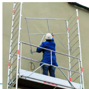
Mise en place des garde-corps La fixation des garde-corps est impérative pour passer à l'étape suivante
